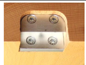
Stufenteil: eingefräst für Stufe bündig
