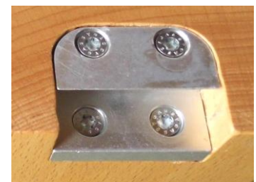
Stufenteil: eingefräst für Schattenfuge
